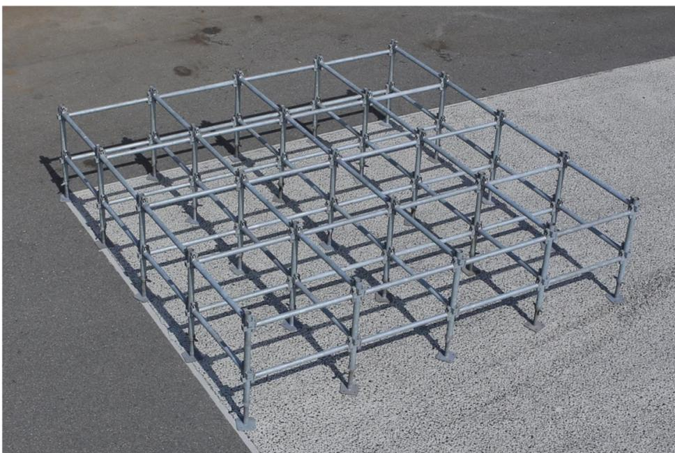
④端から横並びにステージ枠を取り付けます
