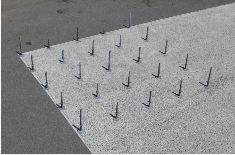
②パイプジャッキに支柱を立て、手摺で連結します
